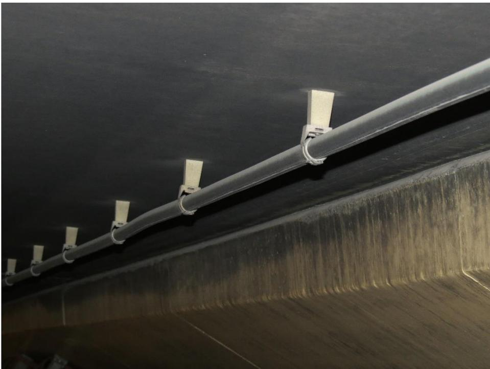
Abbildung 3.9: Beispiel eines Strahlkabels
